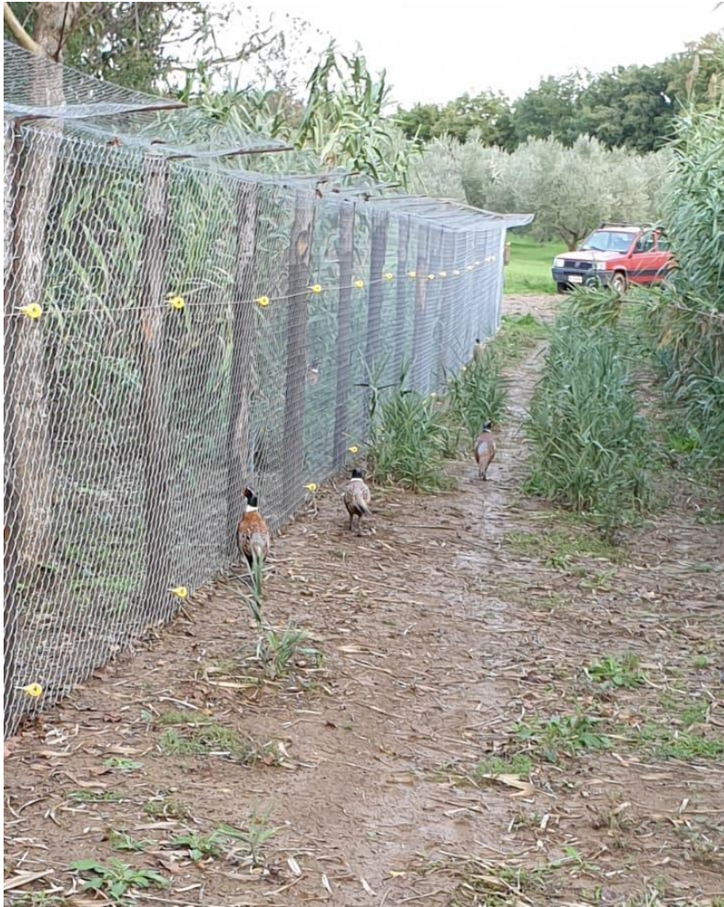
Figura 19: Recinzione con pali in legno e rete anti scavalcamto
