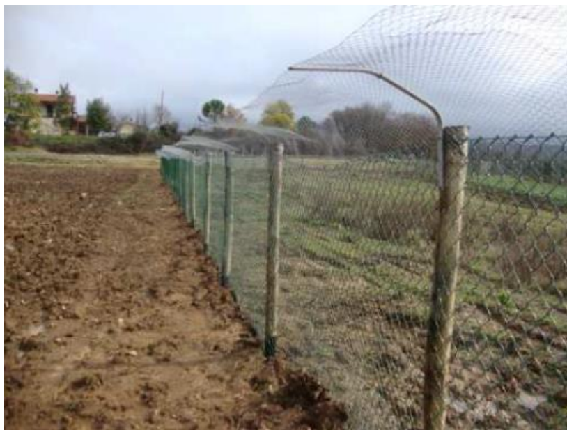
Figura 20: Recinzione con pali in legno e rete anti scavalcamto
