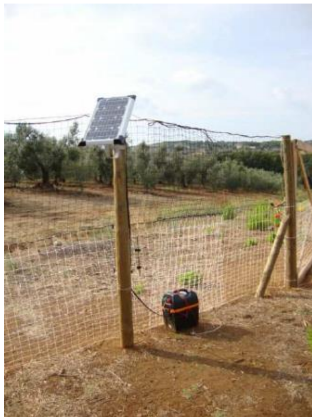
Figura 22: Particolare della batteria e del pannello fotovoltaico
